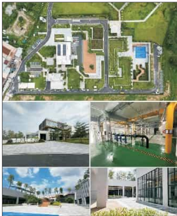
(广州番禺中部净水厂二期工程建成实景)
