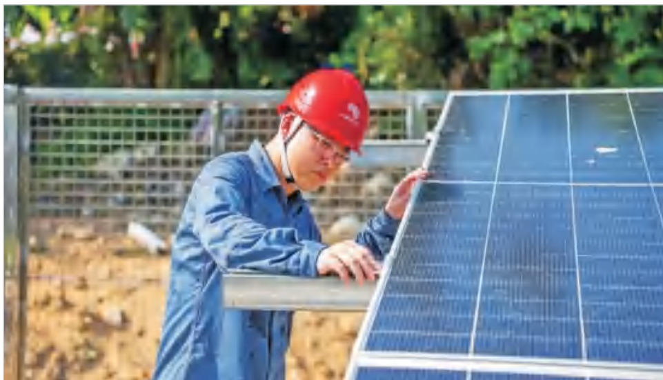
图2-叶林青检查项目建设情况
