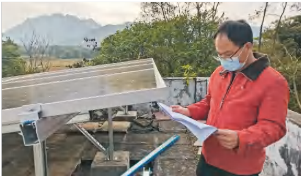
图3-陈振才在石迳小学检查光伏板铺设情况
