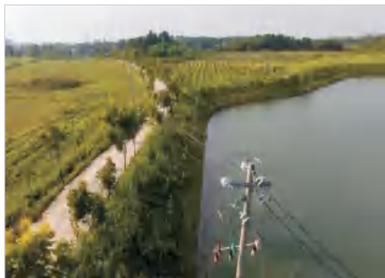
图5. 治理项目完工
