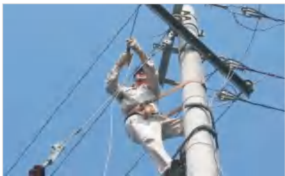
图4. 登杆作业现场
